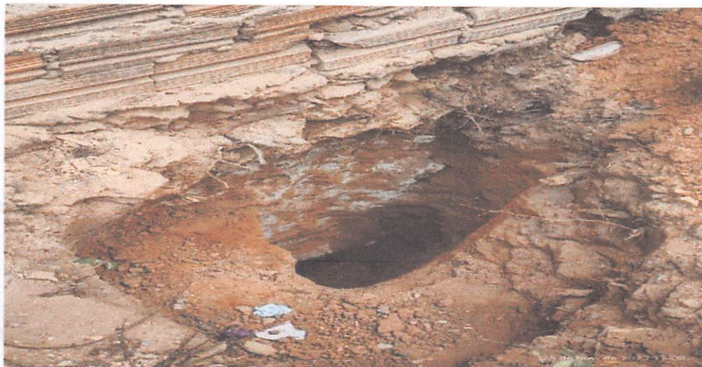
Foto 13: Fundações insuficientes
