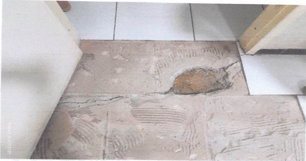
Foto 13: trincas no piso
