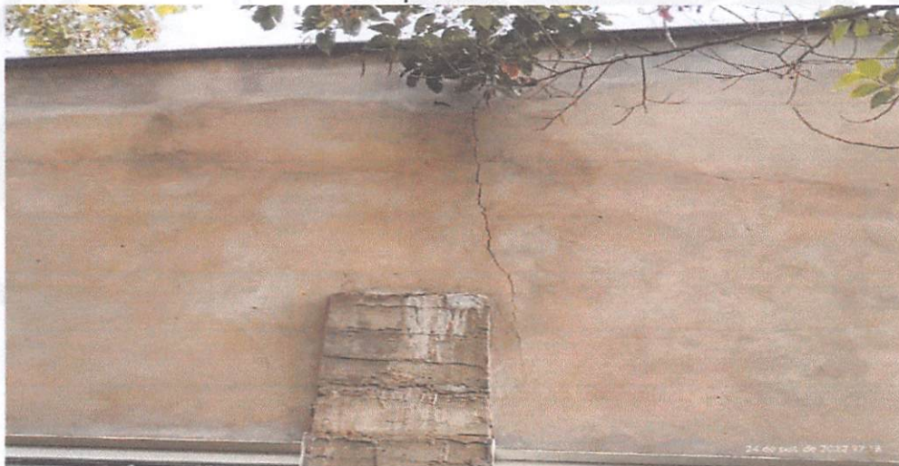
Foto 07: trincas em paredes
