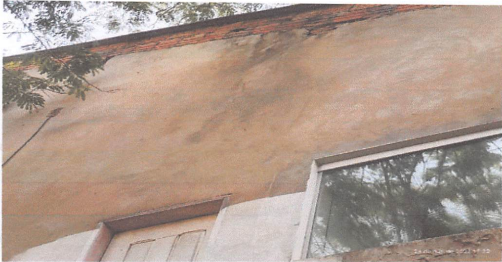
Foto 11: trincas em paredes
