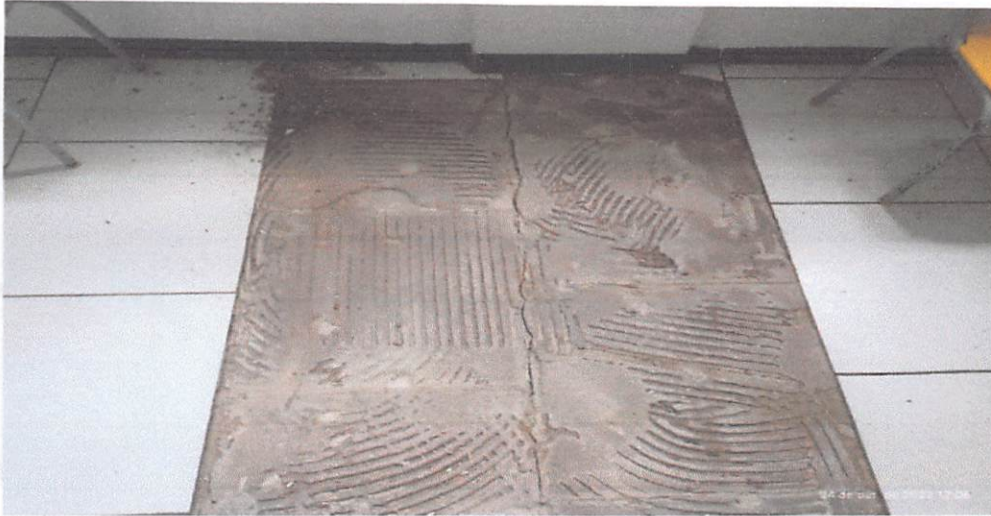
Foto 13: trincas no piso
