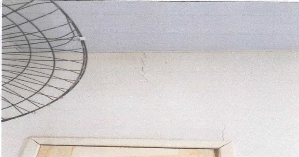
Foto 05: trincas em paredes
