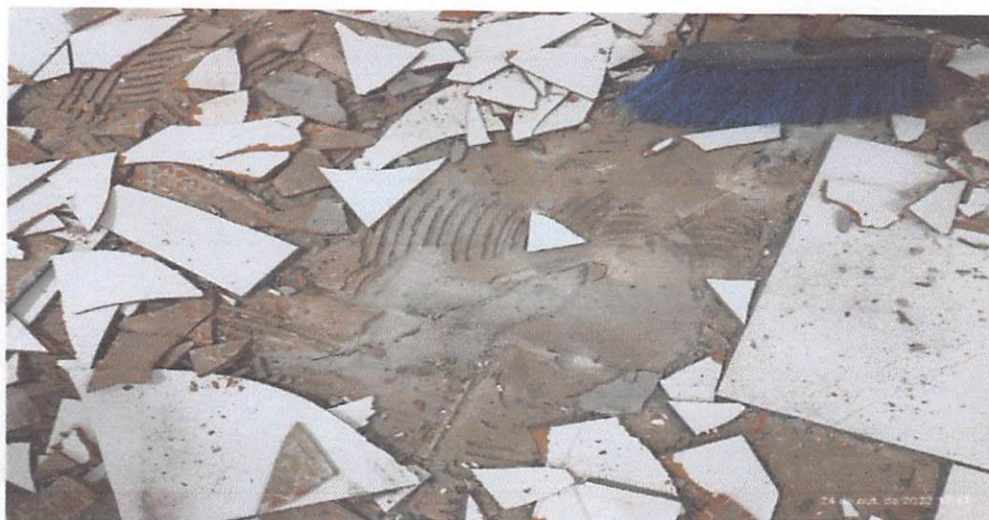
Foto 13: trincas no piso
