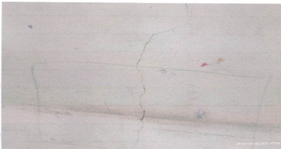
Foto 03: trincas em paredes
