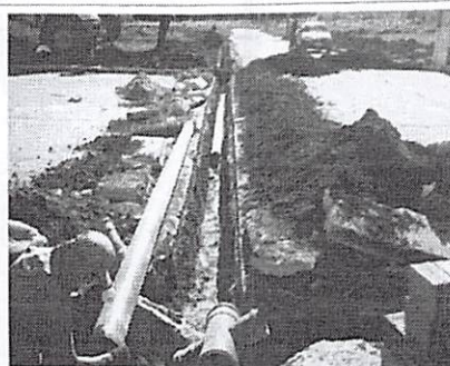
Foto 2: Implantação Rede de Distribuição de Água
