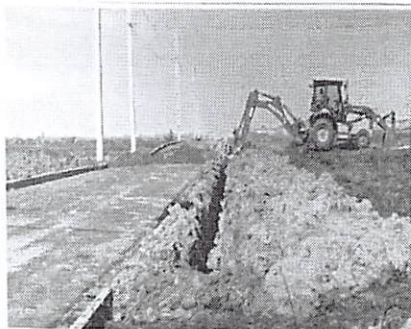
Foto 1: Pavimentação e Escavação mecanizada para Rede de Distribuição de água
