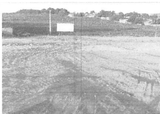
Foto 1: Movimentação de Terra - Terraplenagem
