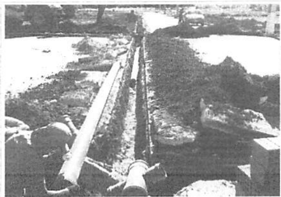
Foto 3: Execução de Rede de Água
