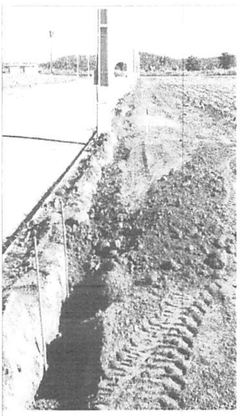
Foto 10: Escavação de Valas – Rede Água
