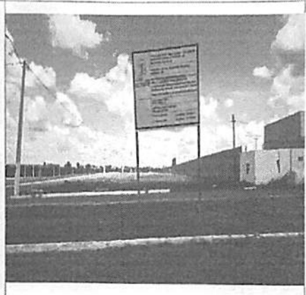
Foto 2: Placa da Obra
