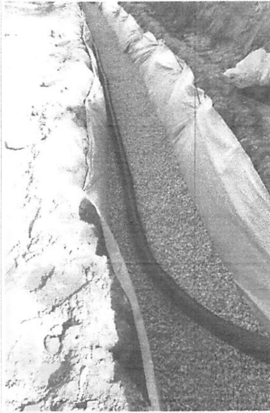
Foto 2: Execução de Drenagem Profunda – Instalação de Tubos PEAD - (Drenagem)
