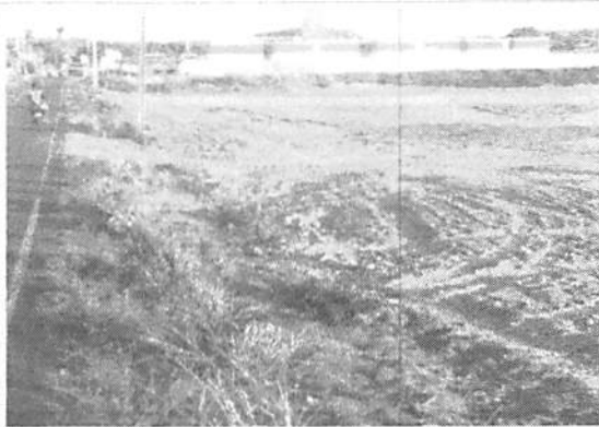
Foto 4: Movimentação de Terra - Terraplenagem
