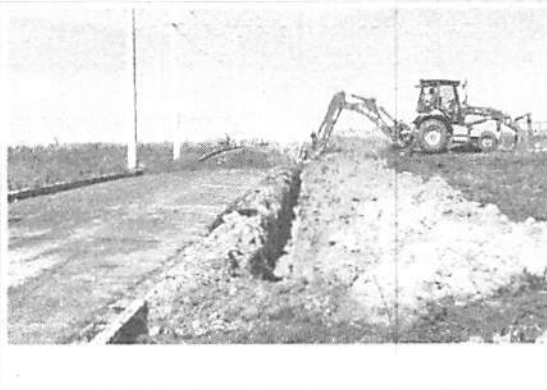
Foto 4: Escavação para passagem de tubulação Água
