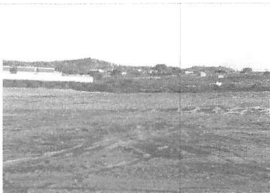
Foto 2: Movimentação de Terra - Terraplenagem
