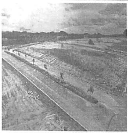
Foto 1: Canteiro Central – Avenida Principal
