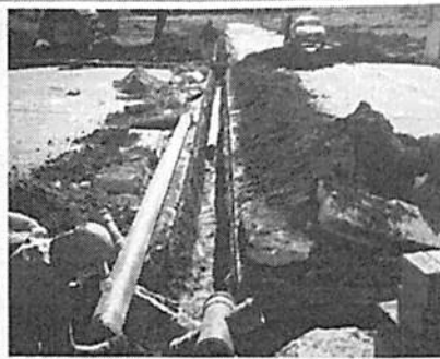
Foto 2: Implantação Rede de Distribuição de Água
