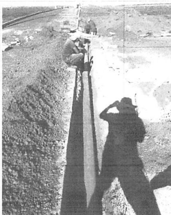
Foto 2: Execução de Rede de Água
