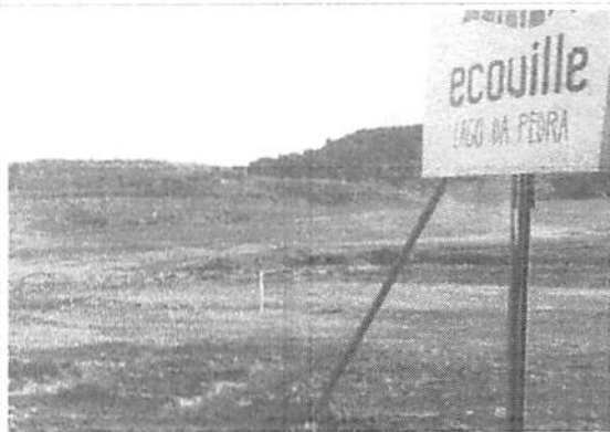
Foto 3: Movimentação de Terra - (Placa do Empreendimento)
