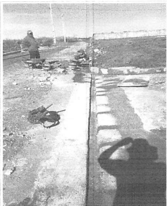
Foto 1: Execução de Passagem Molhada em concreto
